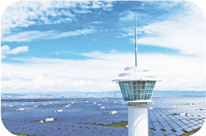
2020年8月17日在海南藏族自治州共和县塔拉滩绿色产业发展园区拍摄的光伏电站 张龙 摄
