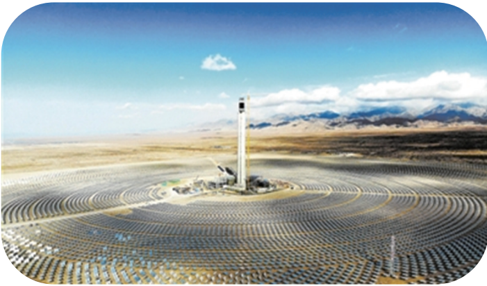
地处海西蒙古族藏族自治州德令哈市的中控太阳能发电有限公司10兆瓦塔式熔盐光热电站 张龙 摄
