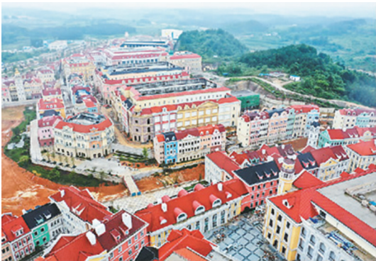
贵州省贵安新区“华为云”数据中心现场 欧东衢 摄
