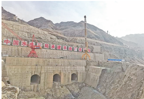
黄河羊曲水电站建设一角
