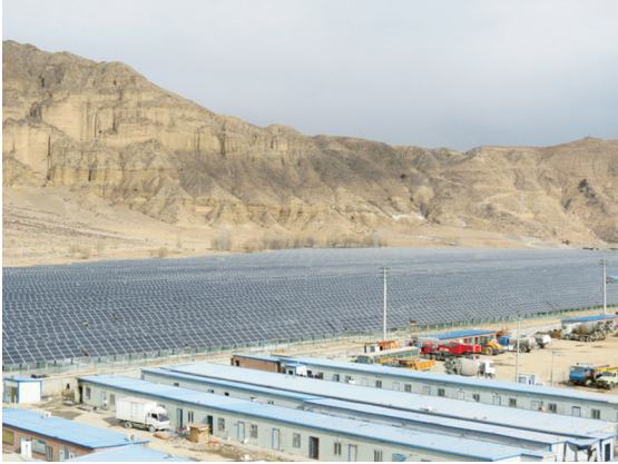
羊曲光伏电站
