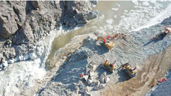
羊曲水电站建设现场
