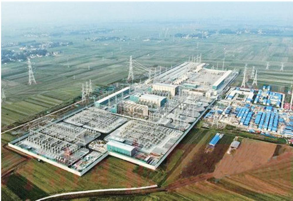
通了!通了!通了!6月29日22时58分,“青豫直流”±800千伏青海-河南特高压直流输电工程实现全线通电,青藏高原的可再生能源直送中原大地。作为世界首条专为清洁能源外送而建设的特高压大动脉,“青豫直流”工程途经青海、甘肃、陕西、河南4省,全长1587千米,总投资约231亿元。工程正式投运后,年输送清洁电能400亿千瓦时。
