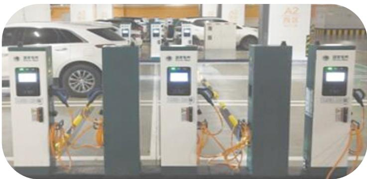
近日,北京规模最大的集中式电动汽车充电站在五棵松体育中心地下停车场投入使用。该充电站共有200个智能充电桩,包括80个60千瓦直流充电桩和120个7千瓦交流充电桩,单日可最大提供约1300车次充电服务。图为五棵松体育中心地下停车场的电动汽车充电站。
