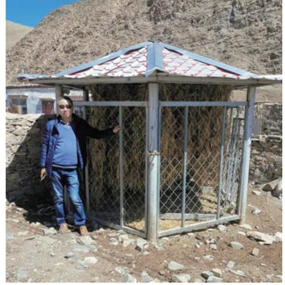
在牧民传统饲草晾晒贮藏方式的基础上,结合藏区气候条件,科研人员设计出两种贮草架,其主要优点是节省空间,贮存量可调节,结构简单,便于拆卸、安装及移动。在保证有效通风的同时,可避免日晒雨淋,防止牲畜随意采食和踩踏。
