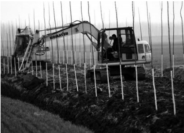
在河南新蔡县余店镇,工作人员使用机械进行高标准农田建设。
