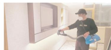
这款产品采用高分子物表涂层技术,将高分子纳米基材、高分子有机物等材料充分融合,能够在物体表面形成致密的网状结构膜。高分子纳米基材可以高效抑制有害污染物挥发。这款产品具有高效、便捷、成本低等特点,可被用在实验室、酒店、会堂等场所。
