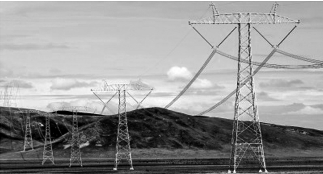
±800千伏青豫特高压直流工程输电线路
