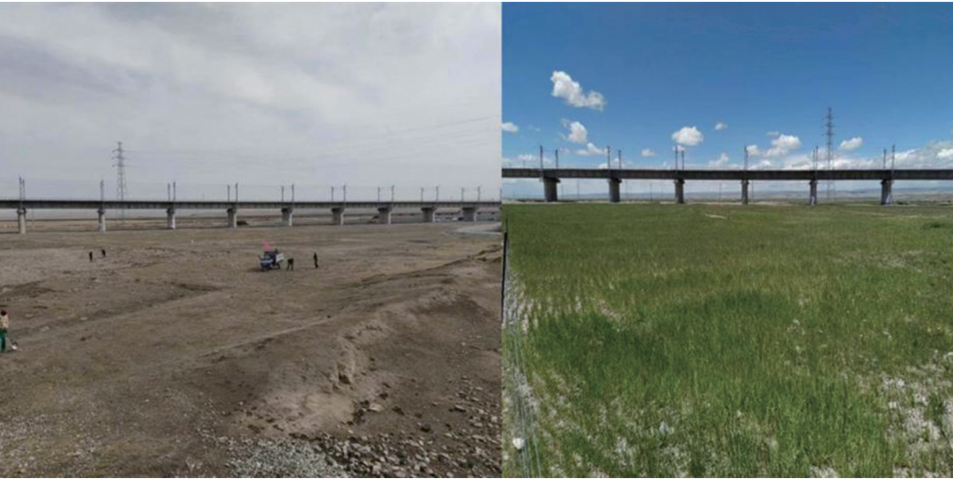
青海省布哈河流域(天峻县区段)水环境治理与修复工程施工前后对比 海西州生态环境局供图
