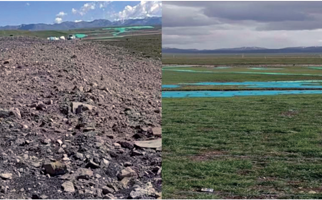
大通河支流江仓曲水环境治理与修复工程施工前后对比 海西州生态环境局供图
