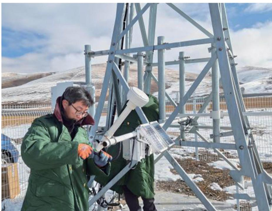
近日,玉树藏族自治州曲麻莱县曲麻河无人基准气候站完成全球气候观测系统地面基准站升级改造工作,标志着三江源全球气候观测系统地面基准站建设完成。据介绍,升级后的曲麻河站增加1雪深、四分量辐射、红外地温要素观测,将为全球气候观测系统地面基准网提供有气候代表性、长时间序列、质量可溯源的地面气候观测数据,其观测数据将与全球高空基准观测站网形成互补,对综合系统数据提供约束、验证的基础。图为技术人员在调试通信系统。
