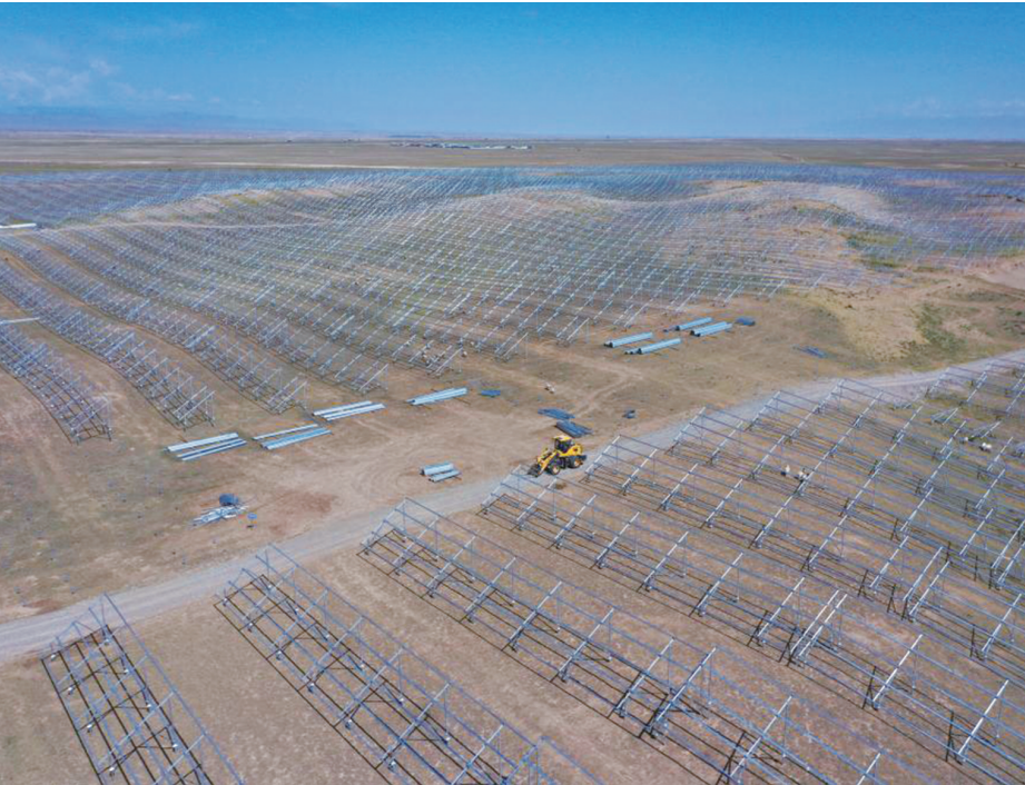
图为工程车辆在黄河上游水电开发有限责任公司海南基地共和县100万千瓦光伏项目施工
