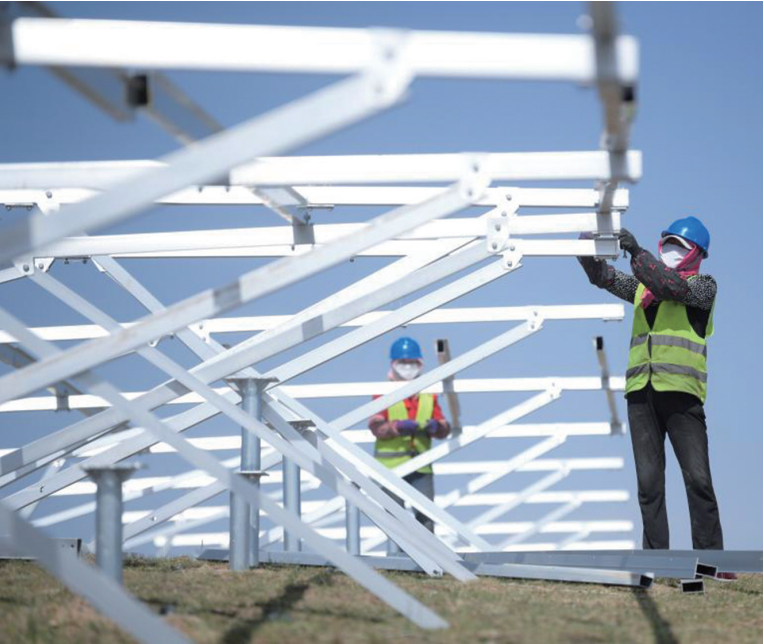
图为工人在黄河上游水电开发有限责任公司海南基地共和县100万千瓦光伏项目施工
