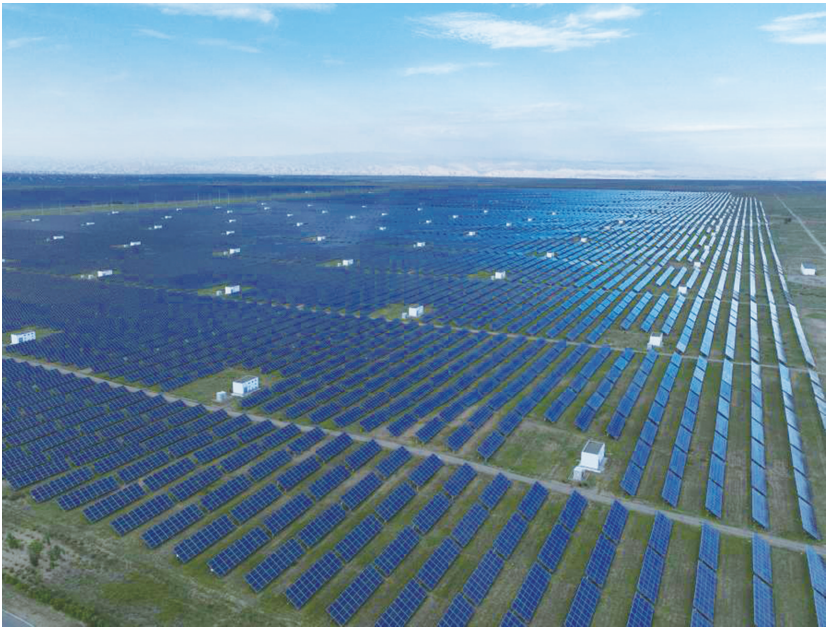
图为海南藏族自治州共和县的光伏电站
