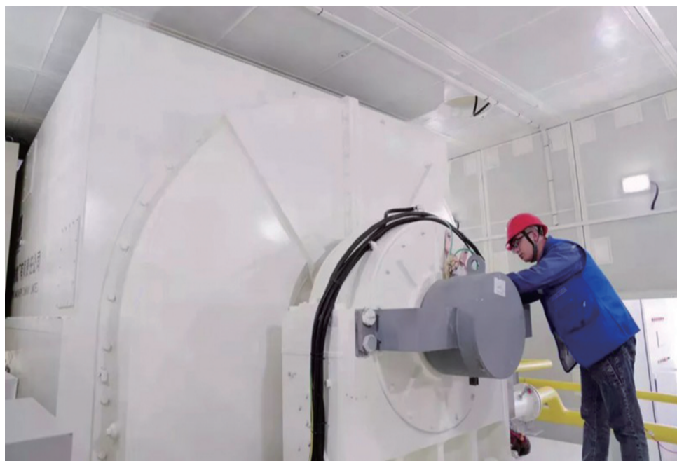
据中新社报道,近日,在我省海南藏族自治州千万千瓦级新能源基地,首批11台新能源分布式调相机全部投入使用,标志着世界最大规模的新能源分布式调相机群正式形成,可带动当地新能源消纳能力提升185万千瓦。图为工作人员正在检查调相机运行情况。图片来源:国家电网报
