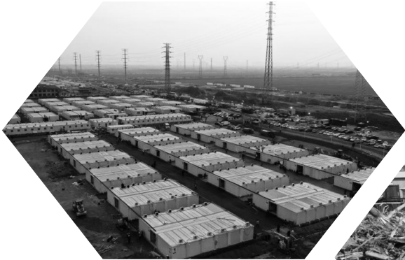
上图为在河北省石家庄市黄庄公寓集中隔离场所工地,工人在整理准备交付房屋的地面(无人机照片)。 杨世尧 摄
